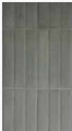
Mur : Carreaux 10*30 - Vert
